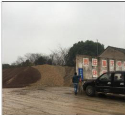
图 3-2 砂石堆放区围墙
