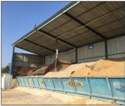
图 3-3 集料仓顶棚和围墙
