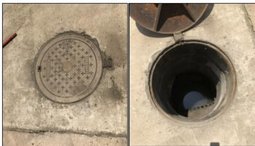
图 4.1-1 厂区污水总排口
