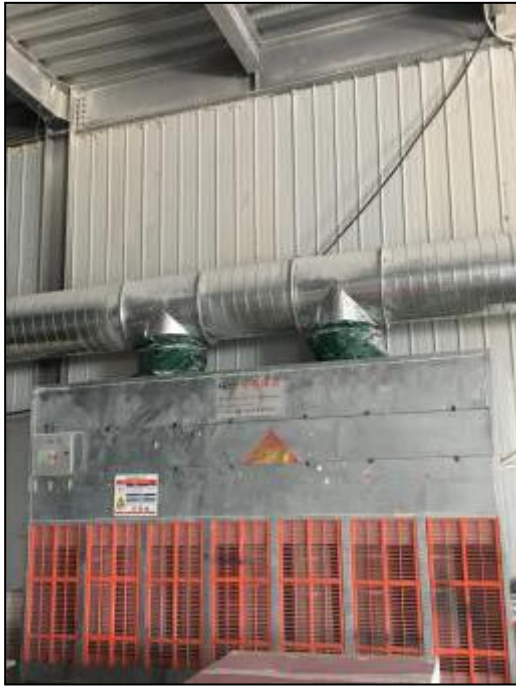
图 4.1-7 脉冲袋式除尘器
