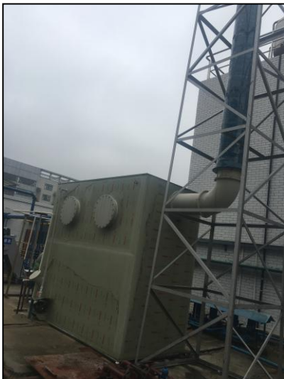
图 4.1-10 恶臭生物滤池+排气筒
