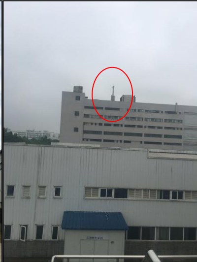
图 4.1-9 2#水洗塔+排气筒
