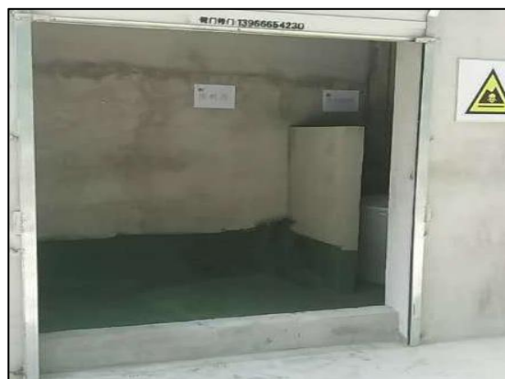
图 4.1-12 地面防腐防渗、围堰
