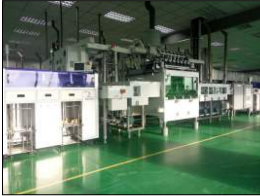
图 4.1-22 生产车间地面防腐防渗
