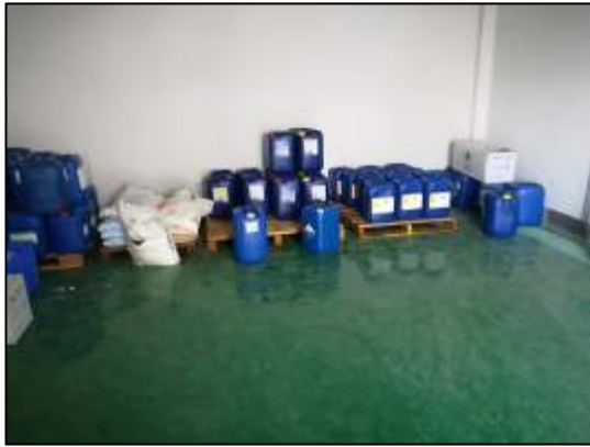
图 4.1-16 地面防腐防渗
