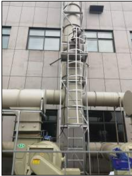
图 1 酸雾喷淋塔废气监测点位
