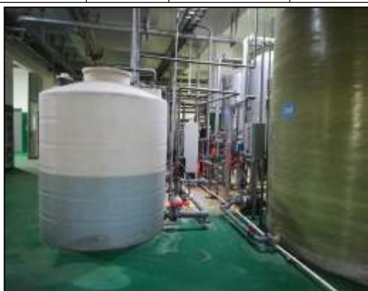
图 4.1-1 污水处理站地面防腐防渗
