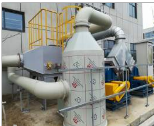
图 4.1-12 水喷淋装置
