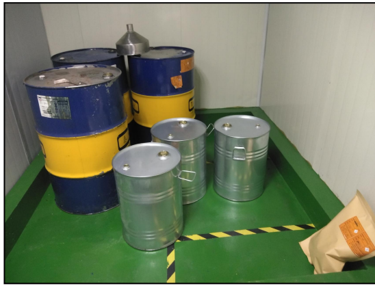
图 4.1-9 围堰图片
