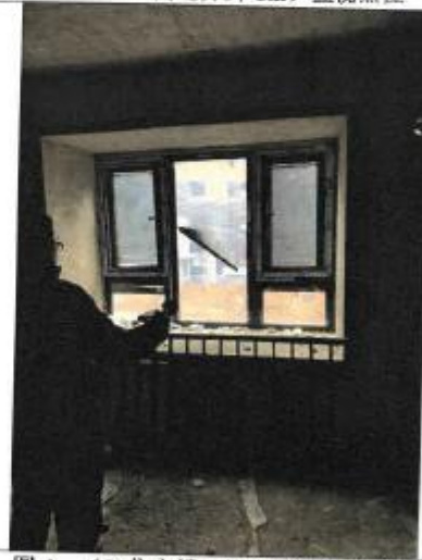
图 4 (5#住宅楼 1 层室内) 监测点位
