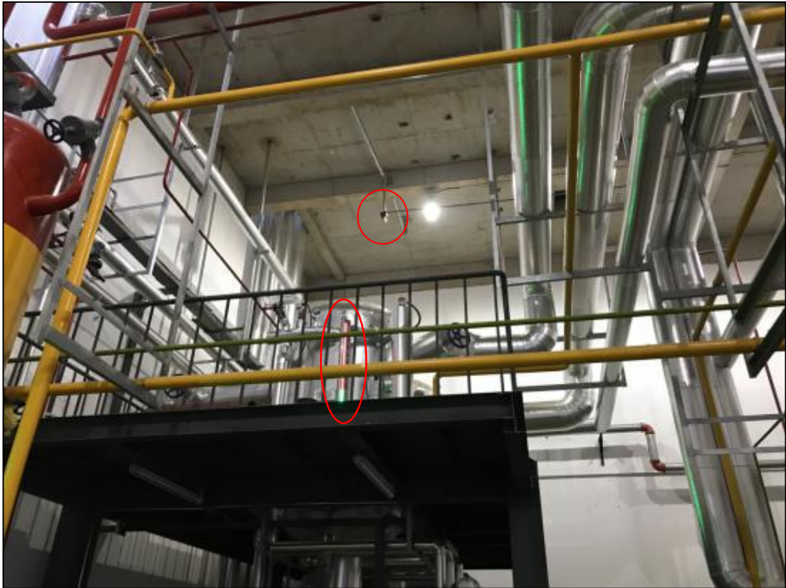
图 4.2-6 高液位报警装置及氨气浓度监控探头
