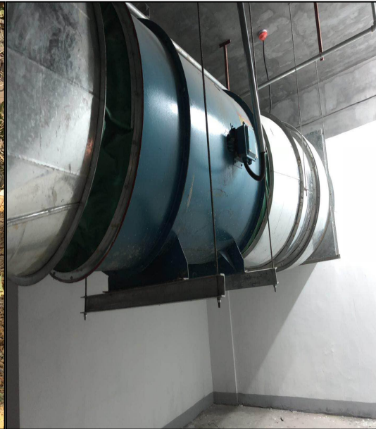
图 4.1-12 风机用减振弹簧吊在半空
