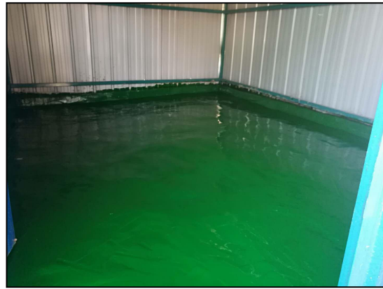
图 4.1-7 危废库内部地面
