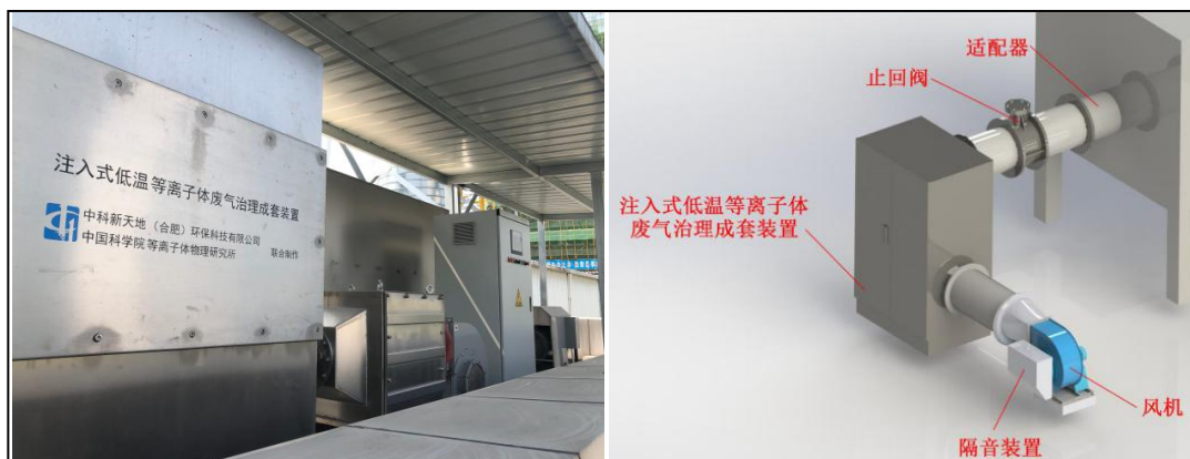
图 4.1-7 吹塑废气注入式低温等离子体废气治理装置
