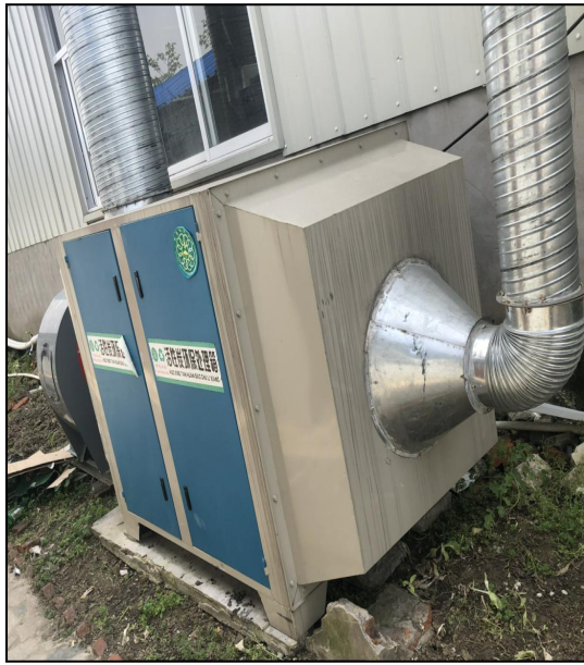
图 4.1-8 挤出成型工序活性炭吸附装置
