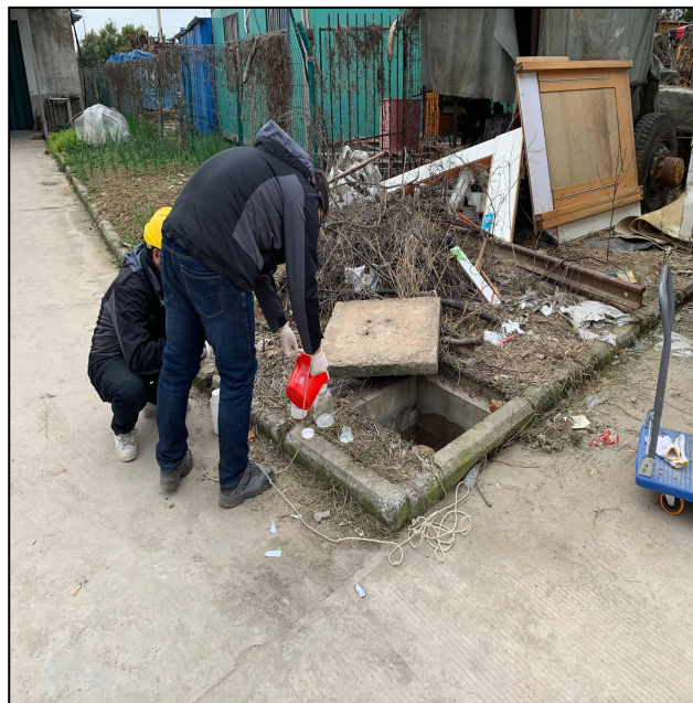
图 4.1-1 厂区化粪池出口
