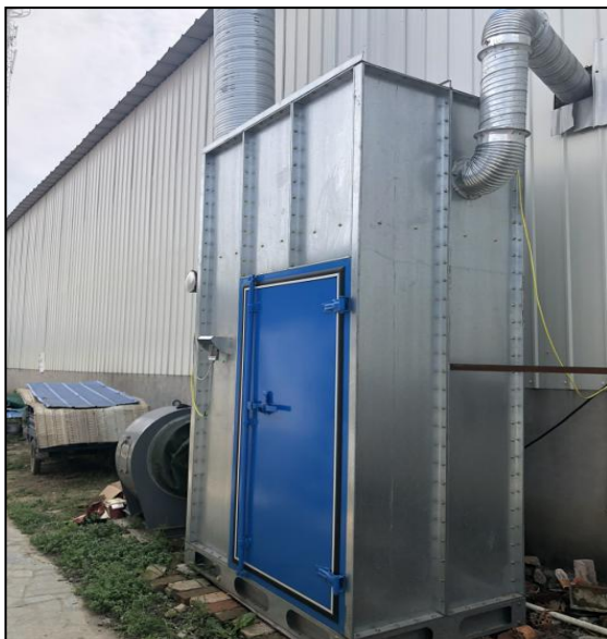
图 4.1-3 修边裁剪工序布袋除尘器
