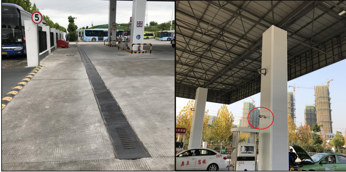
图 4.2-1 站内南侧排水沟
