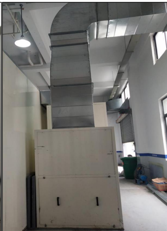
图 4.1-7 活性炭吸附装置+UV 光氧净化器
