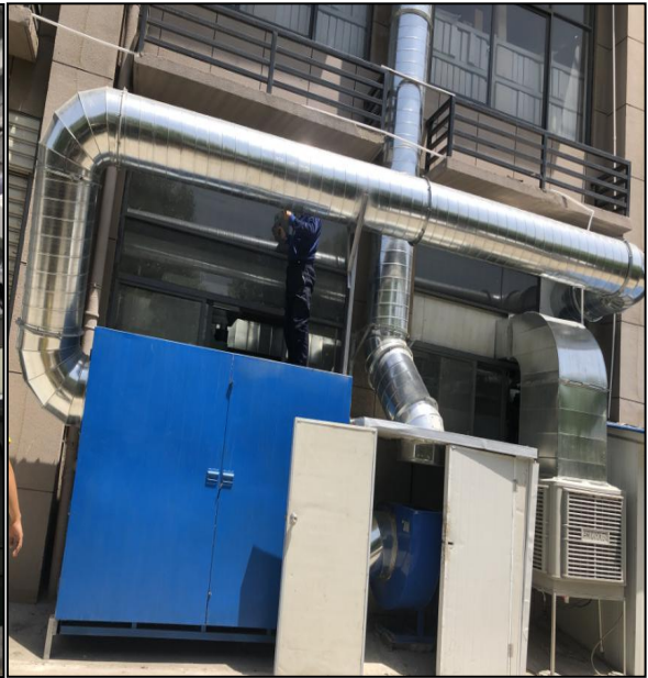
图 4.1-9 成型工序新建活性炭装置
