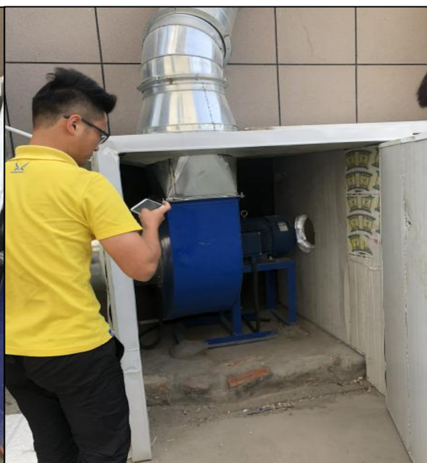
图 4.1-13 厂区西侧单独的风机房
