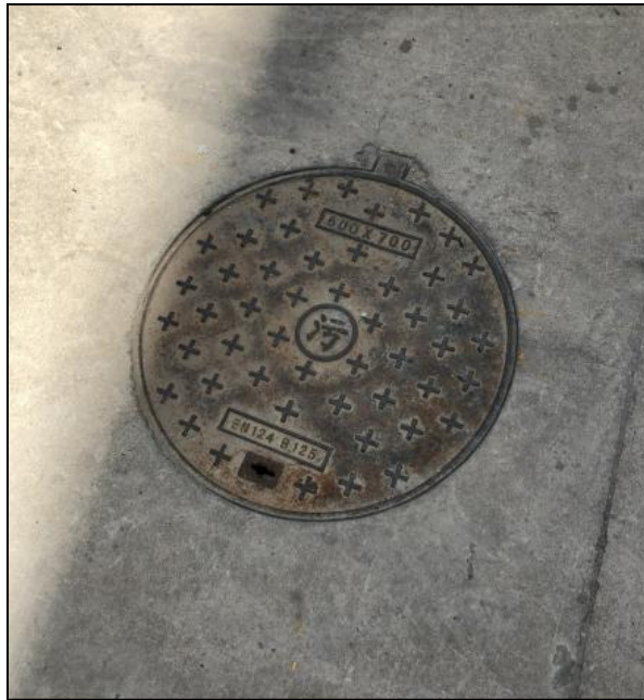
图 4.1-1 厂区污水总排口
