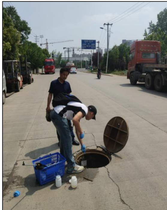
图 4.1-1 厂区污水总排口
