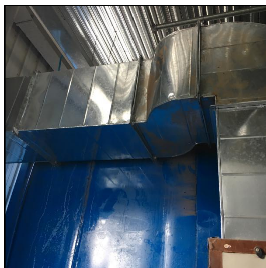
图 4.1-5 2#喷烤漆房排气筒 (P2)
