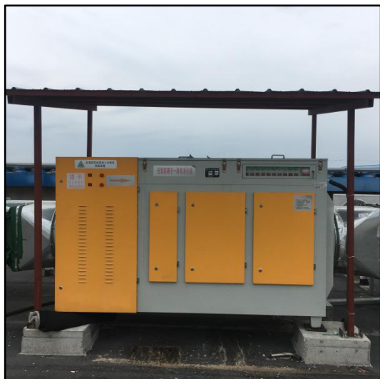
图 4.1-9 等离子光氧催化废气处理一体机
