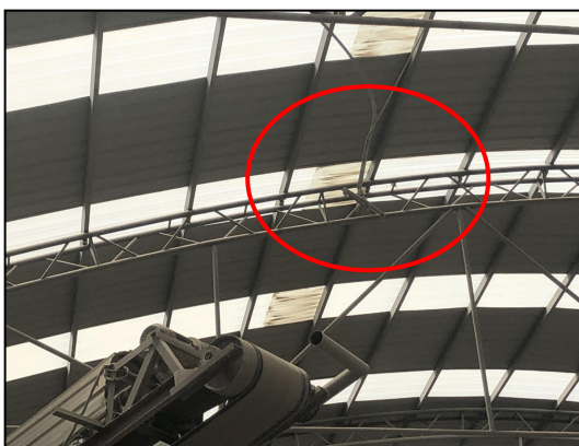
图 4.1-6 雾化喷淋装置
