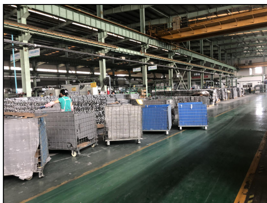
图 4.2.1 生产车间地面防腐防渗
