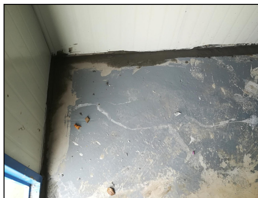
图 4.1.10 危废库地面防腐防渗
