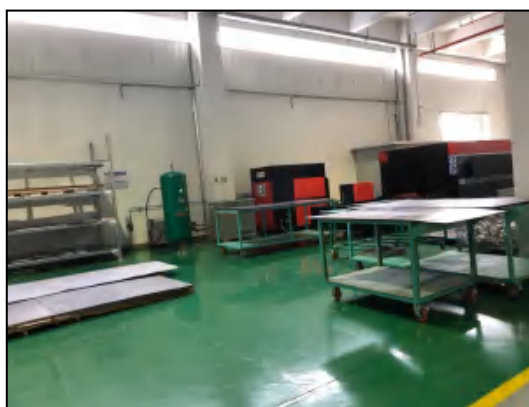
图 4.2.1 生产车间内部地面防腐防渗
