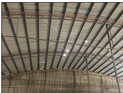
图 4.1-5 封闭生产厂房
