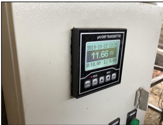
图 4.1-12 pH 监测自动加碱装置
