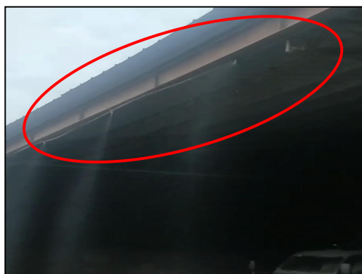
图 4.1-4 雾化喷淋装置
