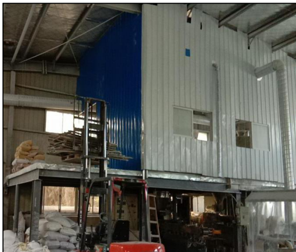
图 4-13 2F 投料机及高辊机封闭空间
