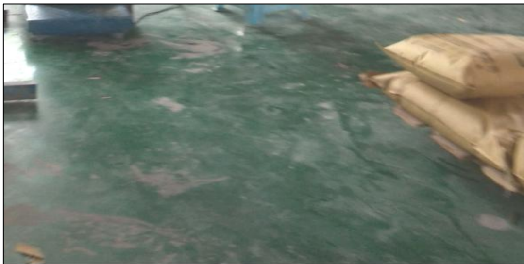
图 4-19 生产厂房内部地面
