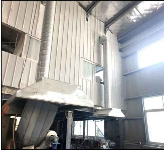
图 4-5 集气罩（注塑机上方）
