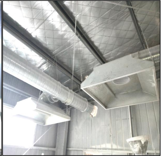
图 4-6 集气罩（投料机、高辊机上方）
