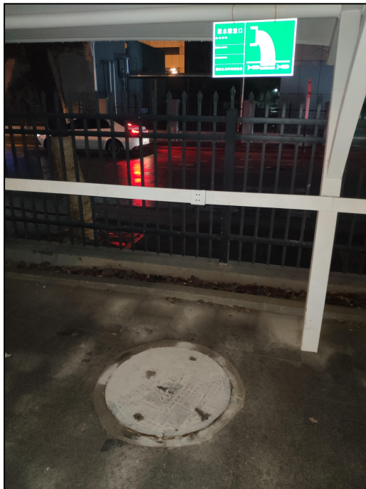
图 4.1-1 雨水总排口照片
