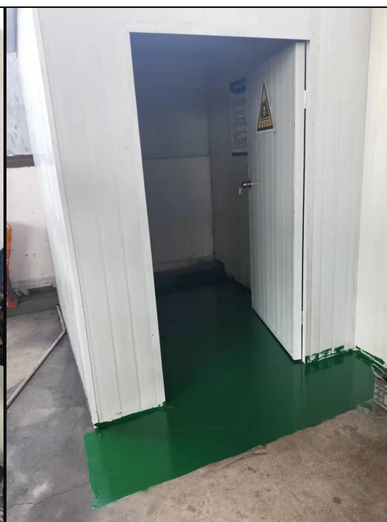
图 4.1-3 危废库内部照片
