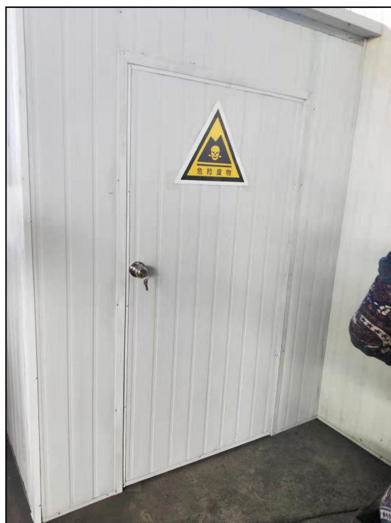
图 4.1-2 危废库外部照片
