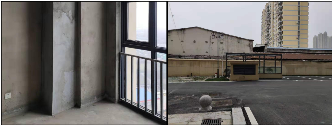
图 4.1-1 预留排烟竖井照片
