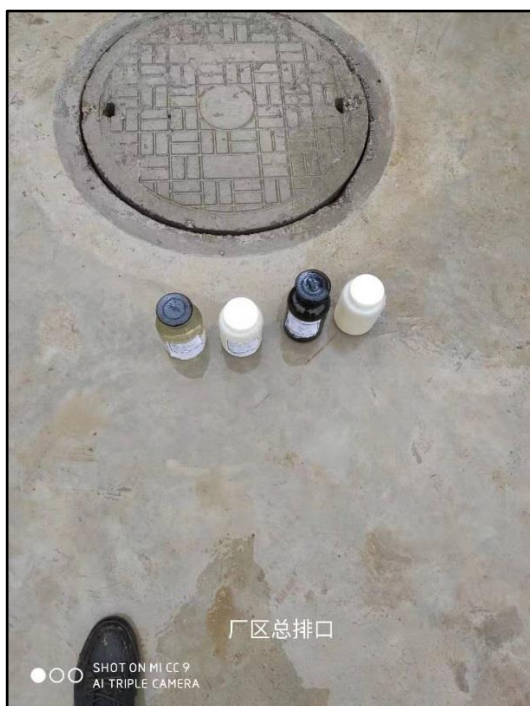
图 1 厂区污水总排口
