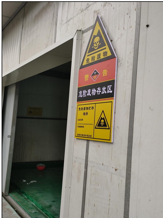
图 4.1-7 危废库外部标牌照片
