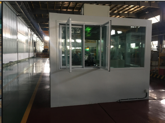
4.1-12 员工操作间隔音罩照片
