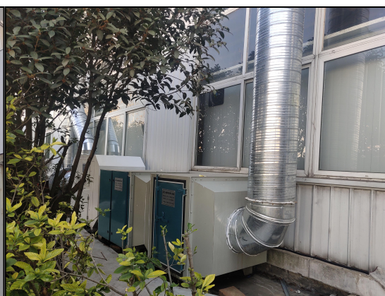
图 4.1-7 干式过滤器和光催化氧化照片
