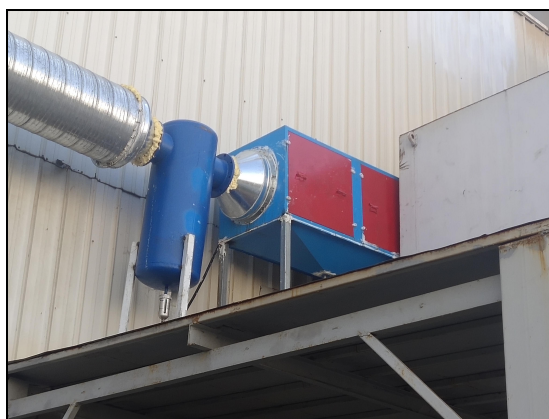
图 4.1-6 旋流分离器照片
