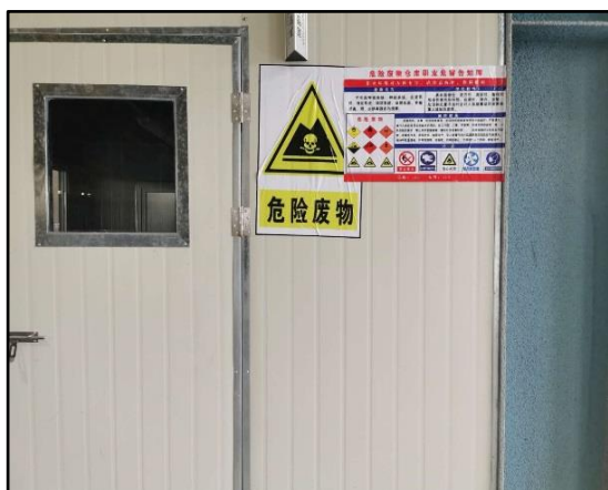
图 4.1-1 项目危废暂存间
