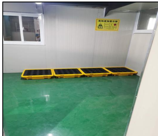
图 4.1-2 地面防腐防渗
