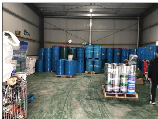
图4.1-14 地面防腐防渗
