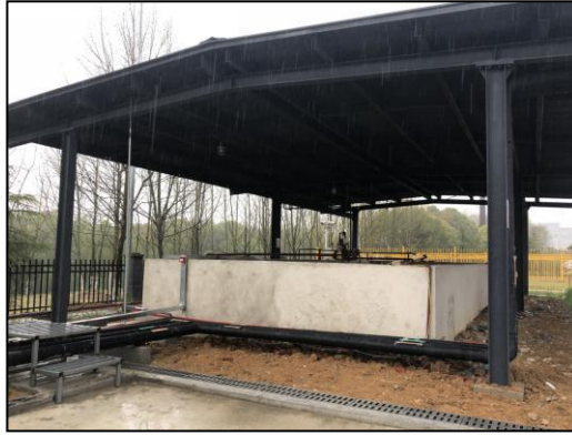
图 4.2-1 地埋式环戊烷储罐区
