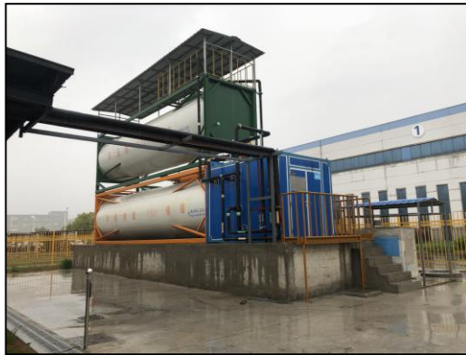
图4.2-10 黑白料储罐区围堰
