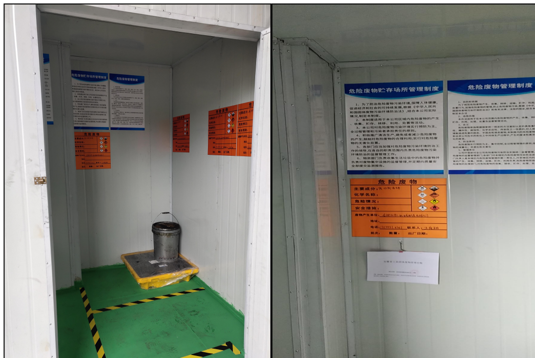
图 4.1-1 危废库内部照片
