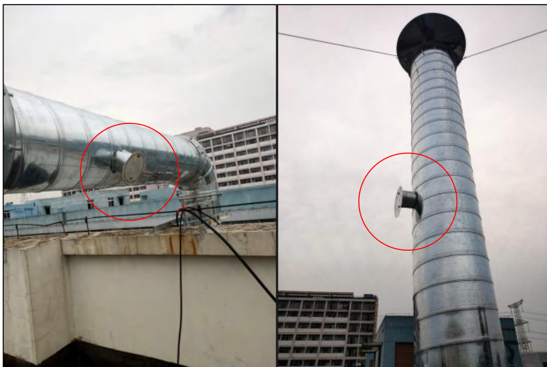
图 4.1-13 进口采样孔
