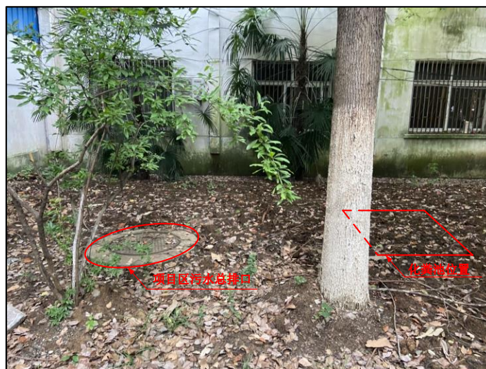
图 4.1-1 项目区化粪池
