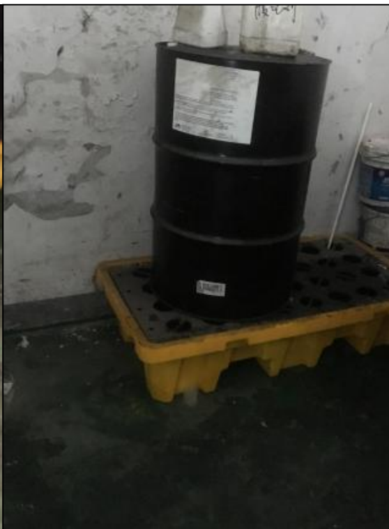
图 4.1-13 防渗漏托盘
