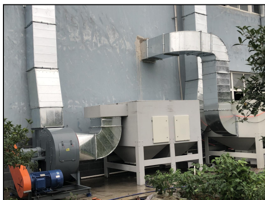
图 4.1-18 焊接烟尘净化器
