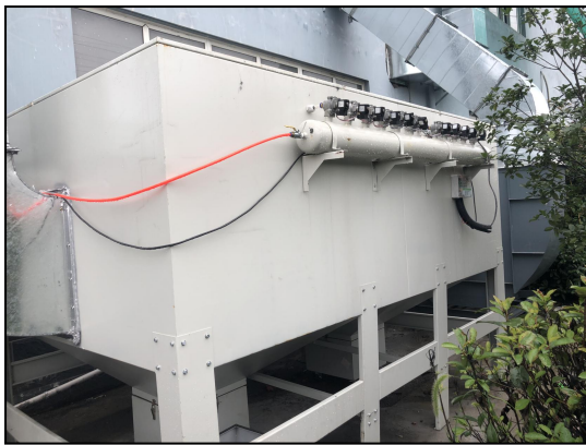
图 4.1-13 滤筒除尘器
