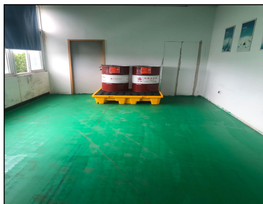
图 4.1-21 地面防腐防渗
