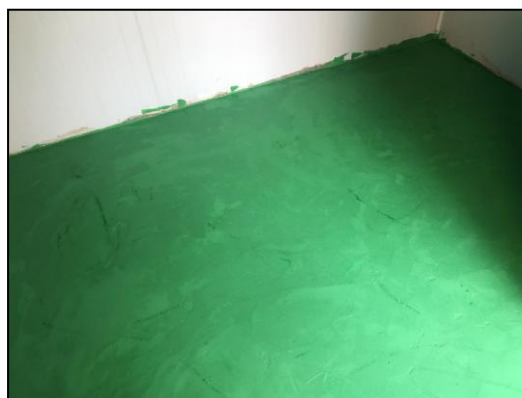
图 4.1-5 地面防腐防渗
