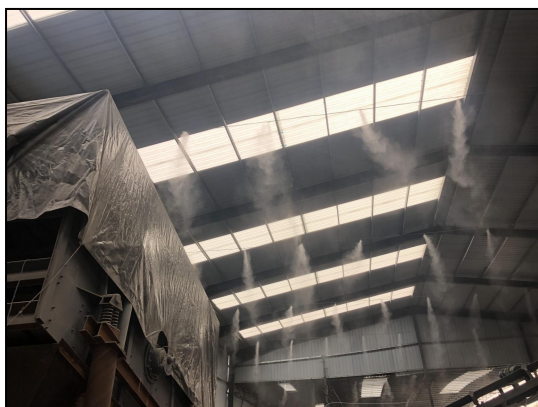
图 4.1-4 雾化喷淋装置
