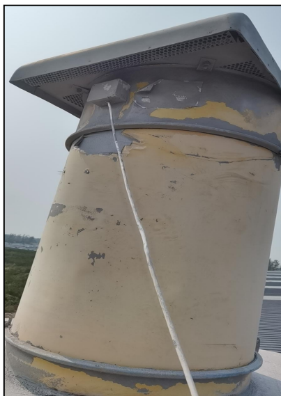
图 4.1-8 仓顶式布袋除尘器
