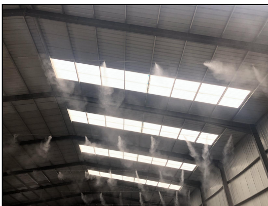
图 4.1-5 雾化喷淋装置
