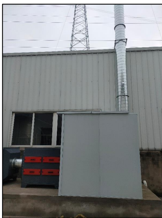
图 4.1-32 风机隔声罩
