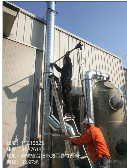
图12 排气筒 P4 出口
