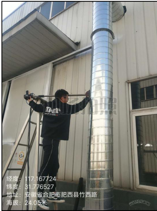
图5 排气筒 P1 进口
