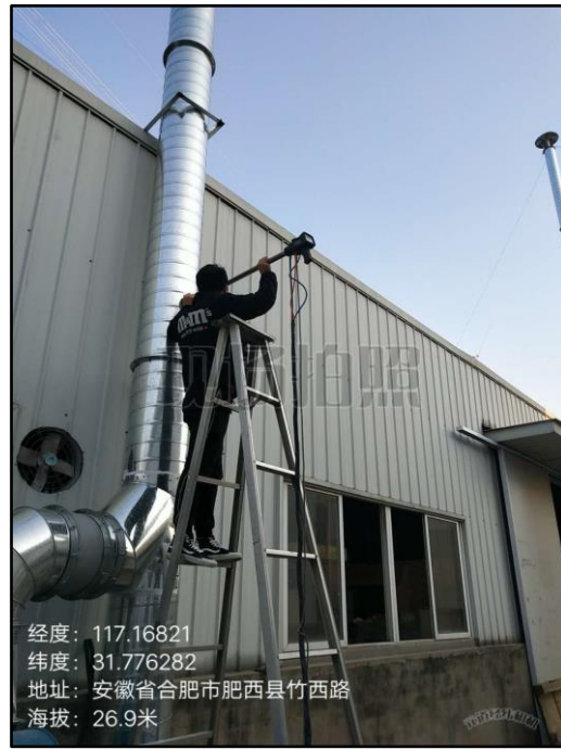
图 14 排气筒 P5 出口
