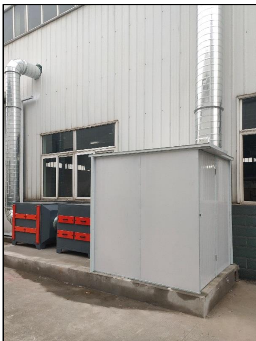
图 4.1-31 风机隔声罩
