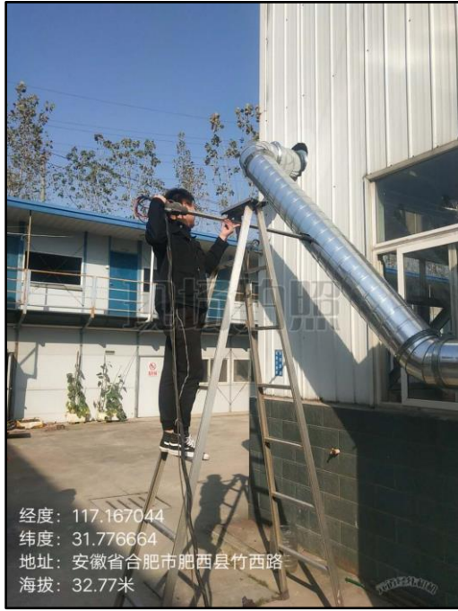
图9 排气筒 P3 进口
