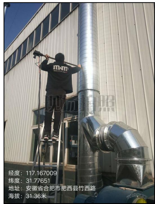
图8 排气筒 P2 出口
