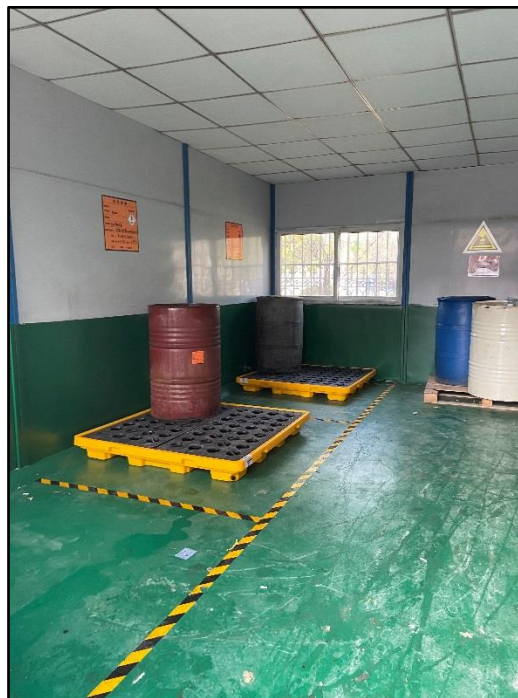
图 4.1-32 地面防腐防渗
