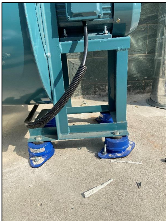
图 4.1-29 基础减震
