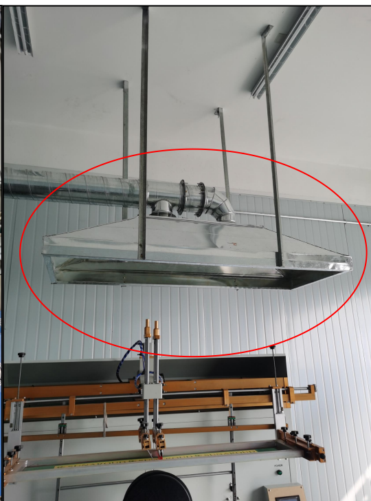
图 4.1-6 丝印工序集气罩
