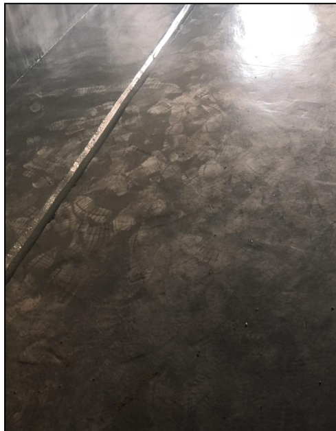
图 4.1-19 地面防腐防渗
