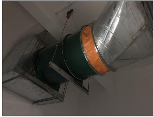
图 4.1-5 风机减振弹簧
