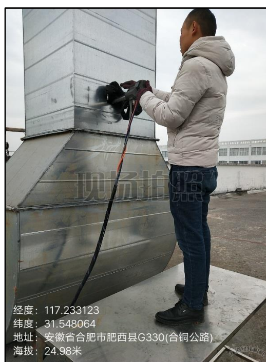
图 4 排气筒 P2 出口
