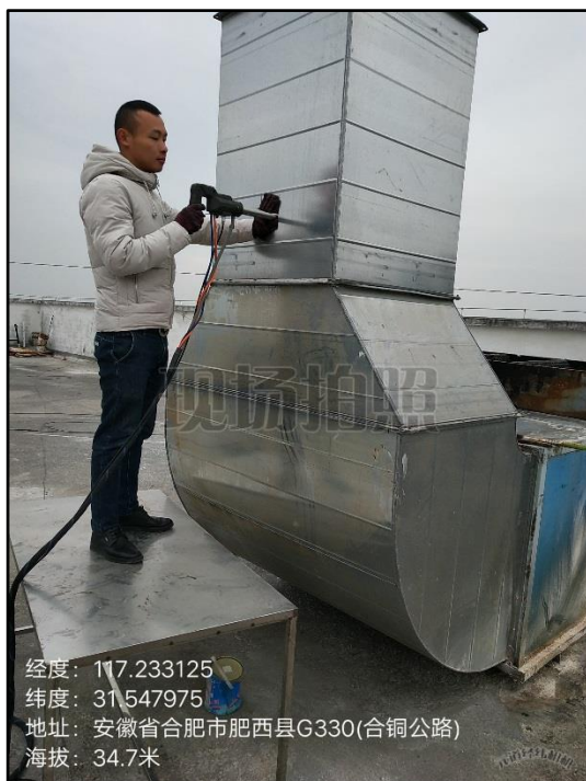
图 3 排气筒 P1 出口
