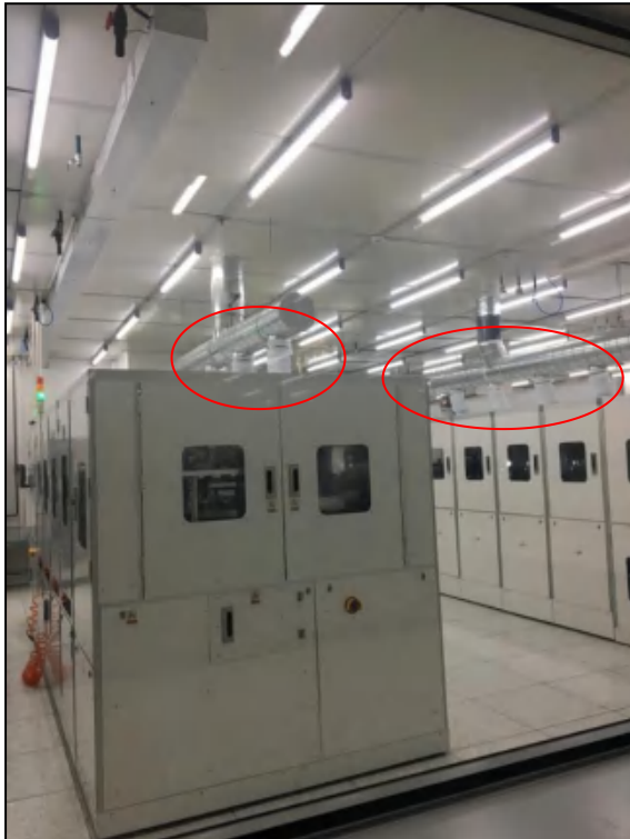
图 4.1-18 非甲烷总烃收集系统
