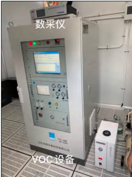
图 4.1-41 VOCs 在线监测装置
