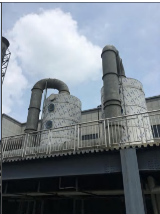
图4.1-16 酸雾喷淋塔
