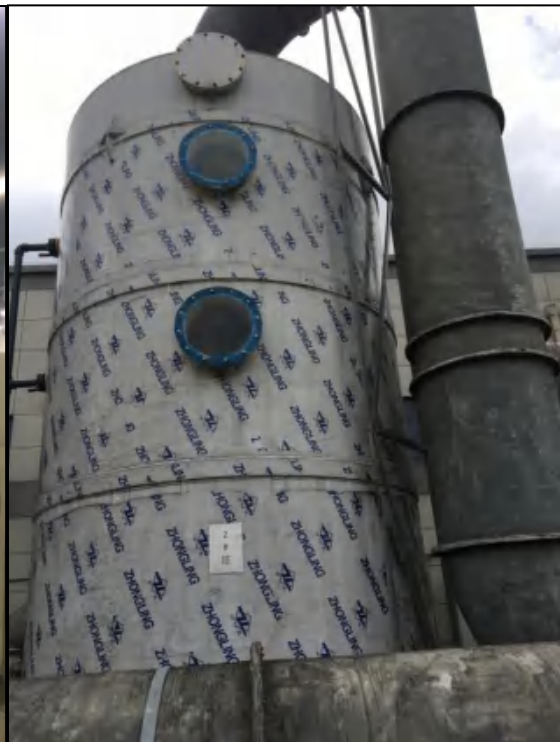
图4.1-14 酸雾喷淋塔
