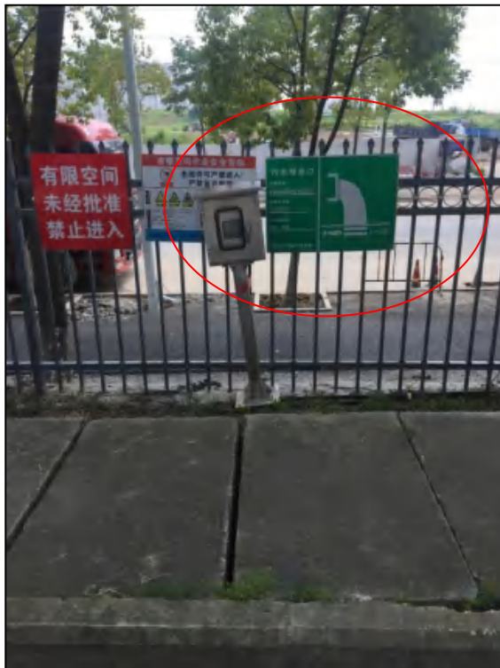
图 4.1-43 污水总排口规范化
