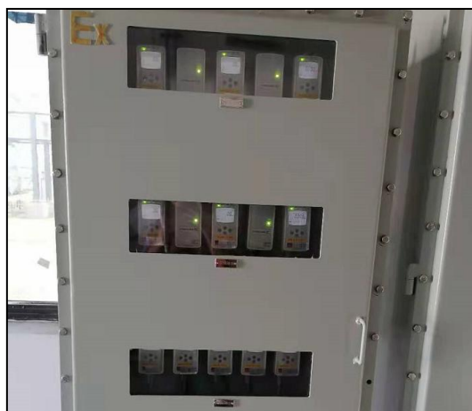
图 4.1-25 泄漏报警装置
