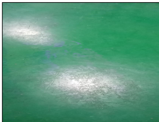
图 4.1-15 地面防腐防渗
