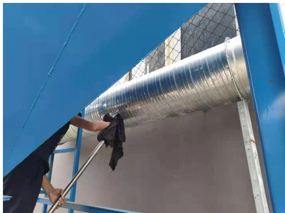
图 5-7 有组织废气监测照片（P2 排气筒进口）
