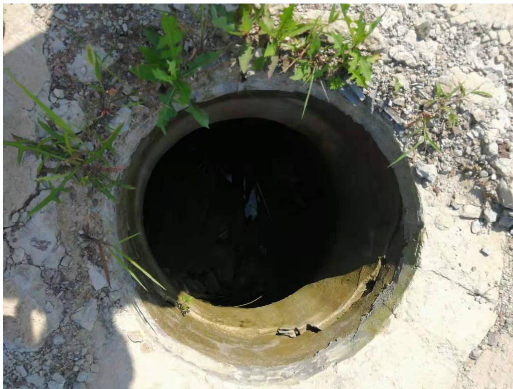
图 4.1-1 厂区污水总排口照片
