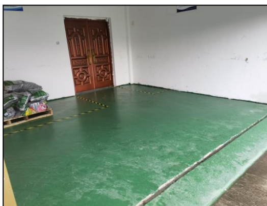
图 4.1-16 地面防腐防渗、导流沟
