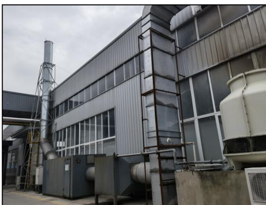
图 4.1-14 原有废气处理设备
